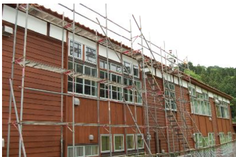
修繕工事の様子
