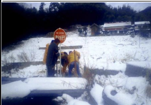
看板設置作業の様子
